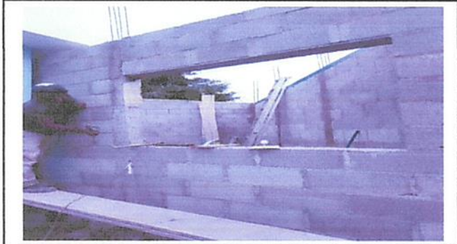
Sustitución de lamina por block en cocina
